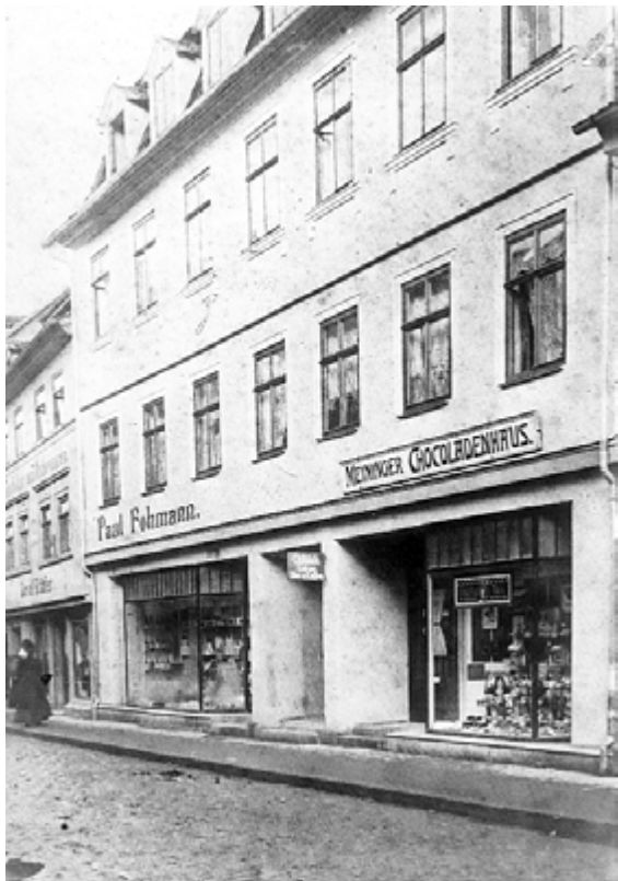
Wohnhaus Anton-Ulrich-Straße 29 um 1900, Archiv Foto-Jahr
